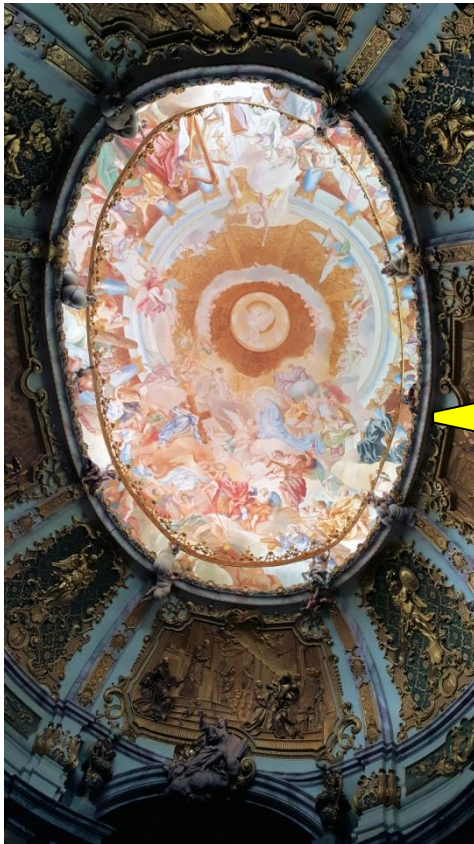
Blick auf die Kuppel . Durch die verdeckten Fenster kommt das Tageslicht
