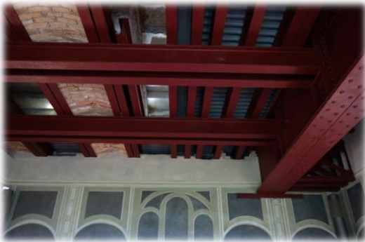
Die technisch aufwändige Konstruktion aus mächtigen, genieteten Doppel - T- Stahlrägern, die wegen des abgeänderten Thronsaales nötig war, ist unterhalb es Thronsaales, im Bistro freigelegt.
